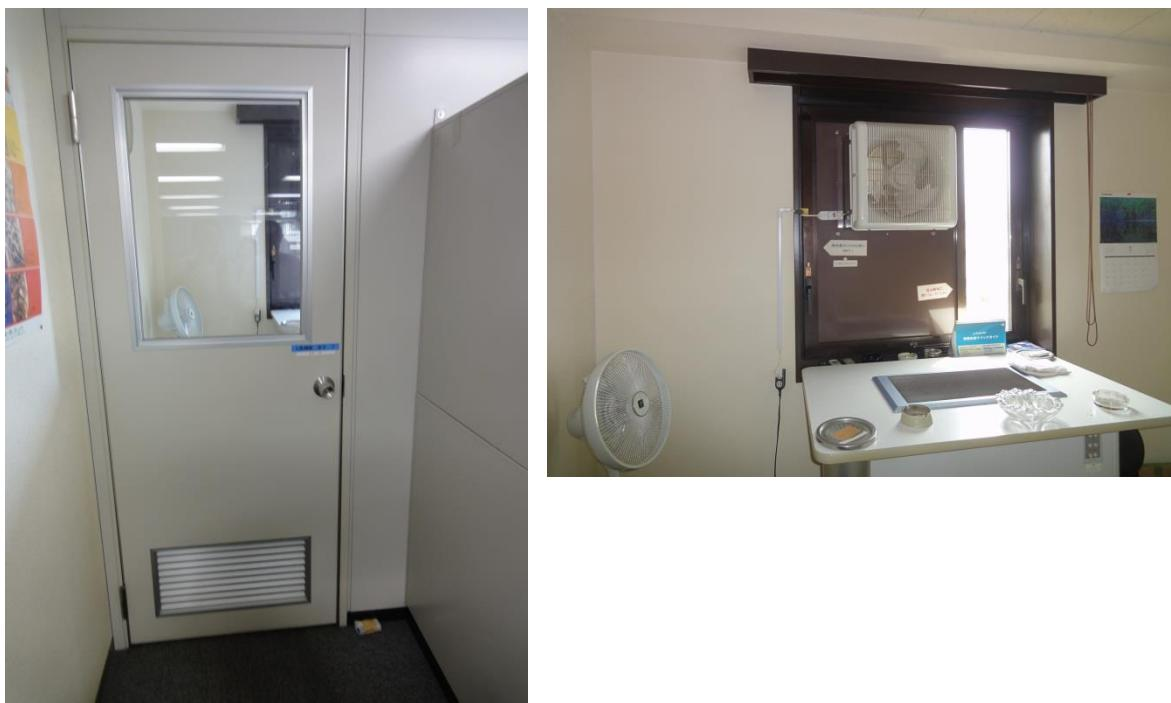
喫煙室（2.7m×1.8m）の入口ドアの反対側に屋外に面した回転窓（1.5m×1.5m位）があり、回転窓を開けると屋外から流入する風によりたばこの煙が事務所内に流入する。そのため、回転窓を閉めて喫煙テーブルや空気清浄器を配置したが、喫煙室からたばこの煙を処理しきれず、事務所内にたばこ臭が漂っている状態であった。
