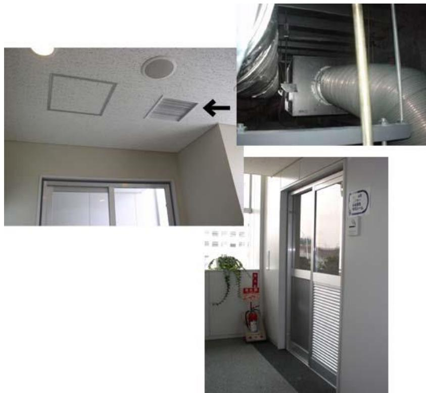
開放されていた出入り口にガラリ<sup>10</sup>のある扉をつけ、天井に排気口、天井裏に排気装置を増設して喫煙室からたばこの煙が漏れ出さないようにした。改善に要した費用は約120万円である。
