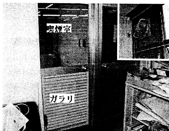
写真3 事例3における空間分煙の内容、改善後写真右上は窓を切り取って設置された排気装置（左：改善前、右：改善後）
