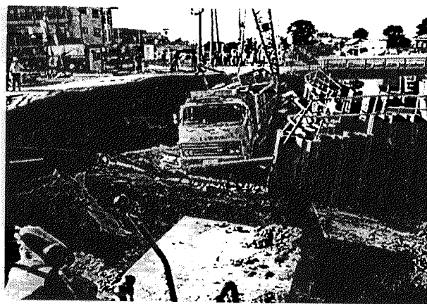
写真2 崩壊現場の状況
